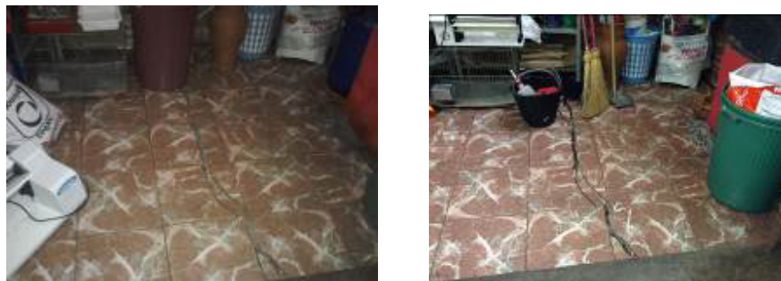
Piso do arquivo - remover todo revestimento e 50% do contra piso em área
