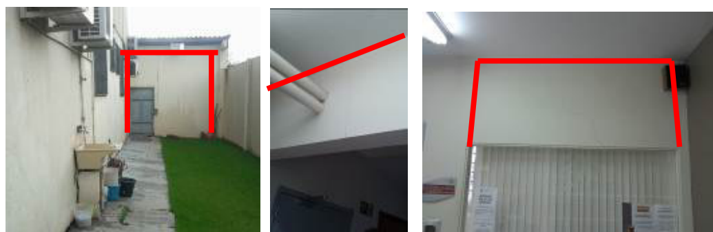
Requadrar/emboçar vãos onde as alvenarias serão removidas
