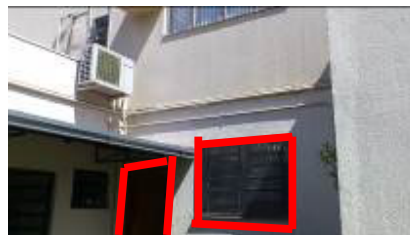
Requadrar/emboçar vãos onde esquadrias serão removidas
