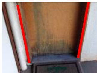
Requadrar/emboçar vãos onde esquadrias serão removidas
